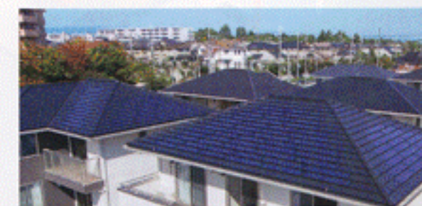
平板瓦一体型太陽電池モジュール設置住宅
