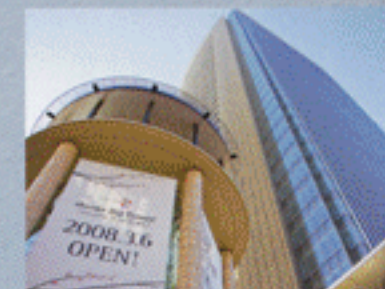
高層ビル(東京都港区)
