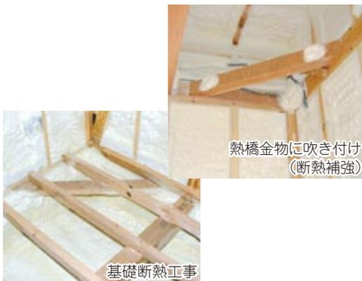
熱橋金物に吹き付け(断熱補強)
